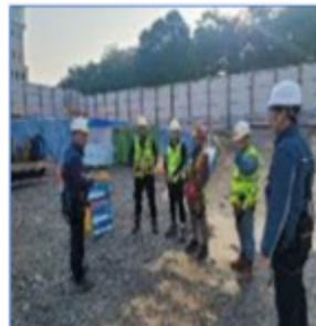
작업 전 안전점검회의
